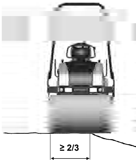
Fig. Positie van de wals bij rijden op wegkanten
